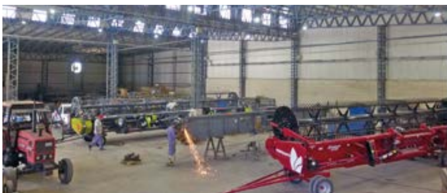
Ampliación de 1500 mts de un galpón existente.
