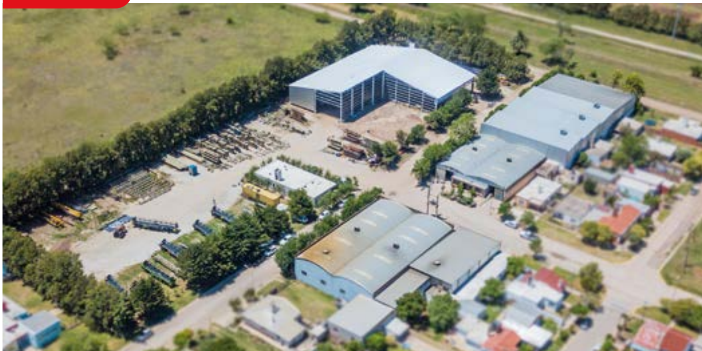
Vista aérea de la expansión: la nueva nave sur y la nueva nave industrial en plena construcción.
