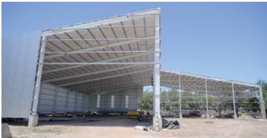
Construcción de nueva nave de 1620 mts destinada a sector de pintura.
